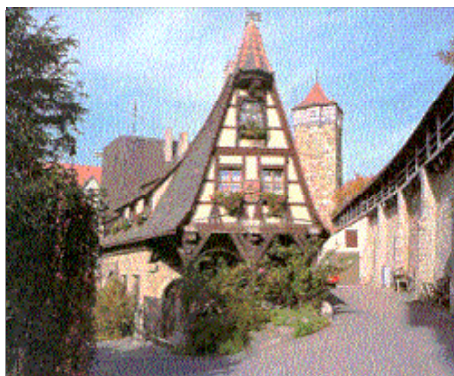
Gerlachschmiede mit Stadtmauer und Röderturm
